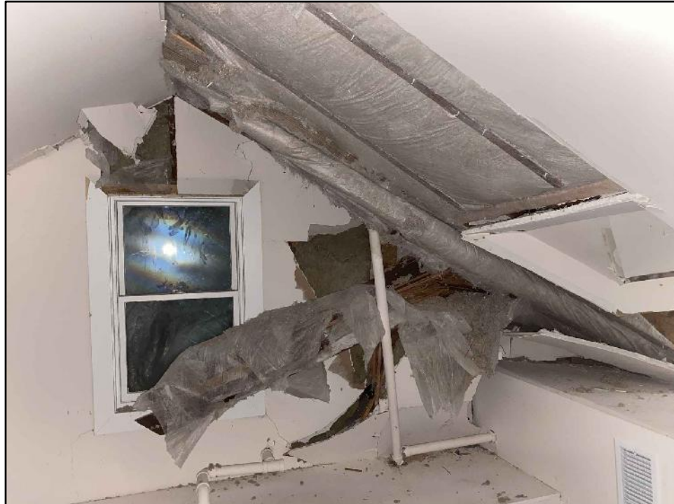
REPLACE WINDOW; REFRAME WALL
